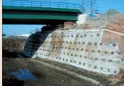
پایدارسازی شیب به روش میخ کوبی
